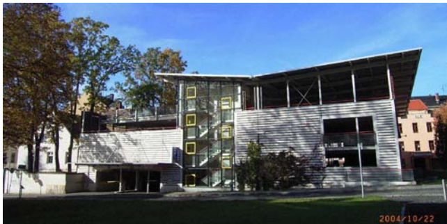
Abbildung 4.4.1.1-54 Parken im Historischen Stadtkern: Parkhaus Pfarrstraße
